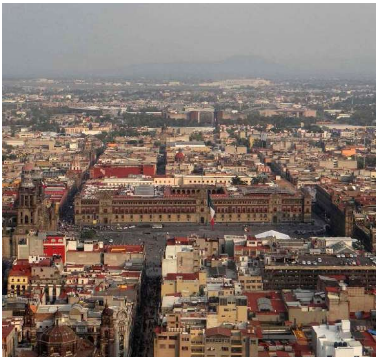
Мексика, Мехико. Вид на площадь со смотровой площадки Torre Latino Americana (Латиноамериканская башня).
